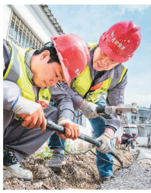
安徽省芜湖市繁昌县繁阳镇范马村东风村民组，供水施工工人正在进行农村供水改造作业。
