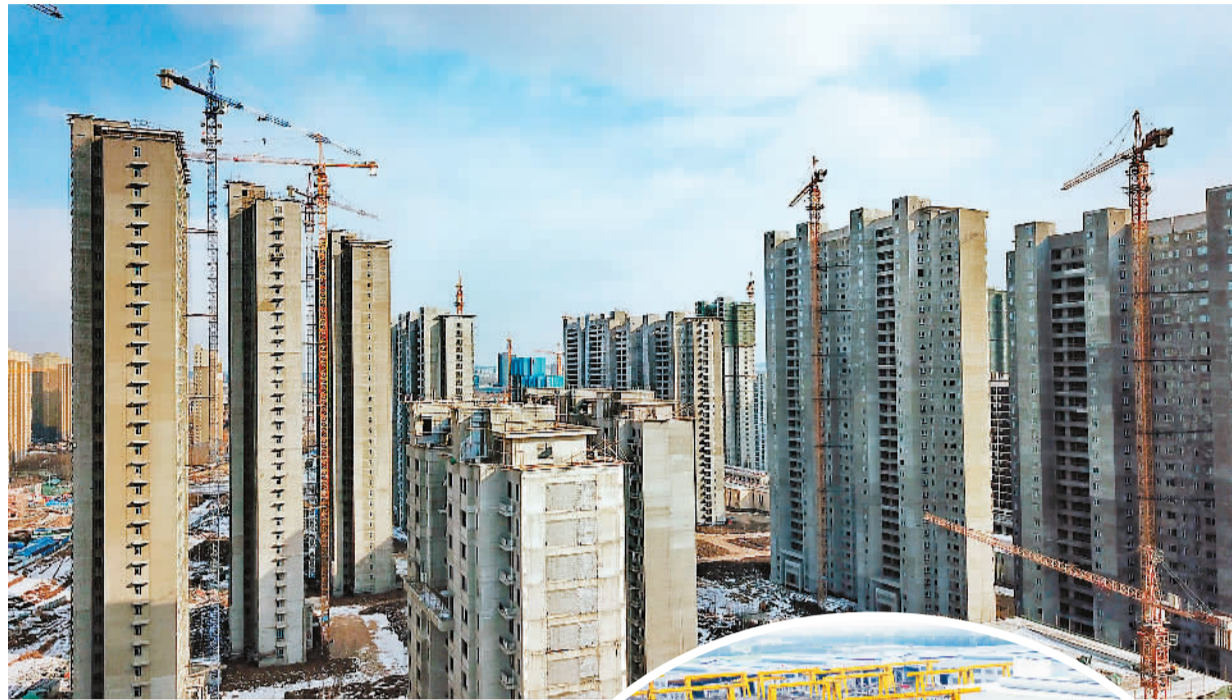
▲2月22日，吉林省长春市生态大街附近的一处在建楼盘正在施工。 新华社记者 张楠摄
