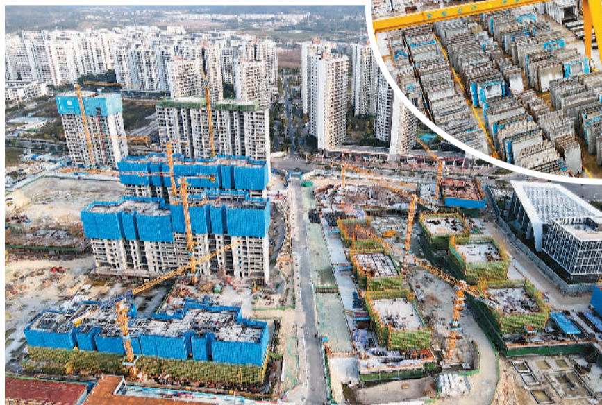
▲海南省三亚市深海科技城综合服务中心项目是海南自贸港重点园区——崖州湾科技城的项目之一，包括科研商务平台、集中式商业中心、商品住宅等。图为2月23日，深海科技城综合服务中心项目施工现场一片忙碌。 新华社记者 张丽芸摄
