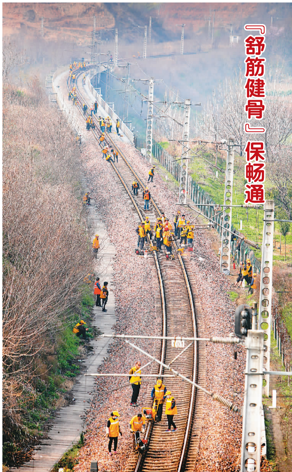
3月15日，中国铁路郑州局集团有限公司南阳工务段组织职工在伏牛山中对焦柳线草店站至交界站间实施应力分散施工。职工采取分段模式，通过“舒筋健骨”对穿越一座桥梁、两个隧道1公里线路上的钢轨进行内部应力均匀调整，有效消除冬季后的设备隐患，保障线路设备状态稳定。
