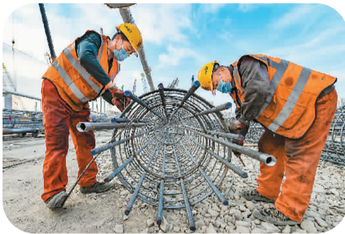
▲北京市副中心站综合交通枢纽工程建成后,京唐城际、京滨城际等将在这里交会。图为2月19日,工人在北京市副中心站综合交通枢纽施工现场忙碌。 孙立君摄(人民视觉)
