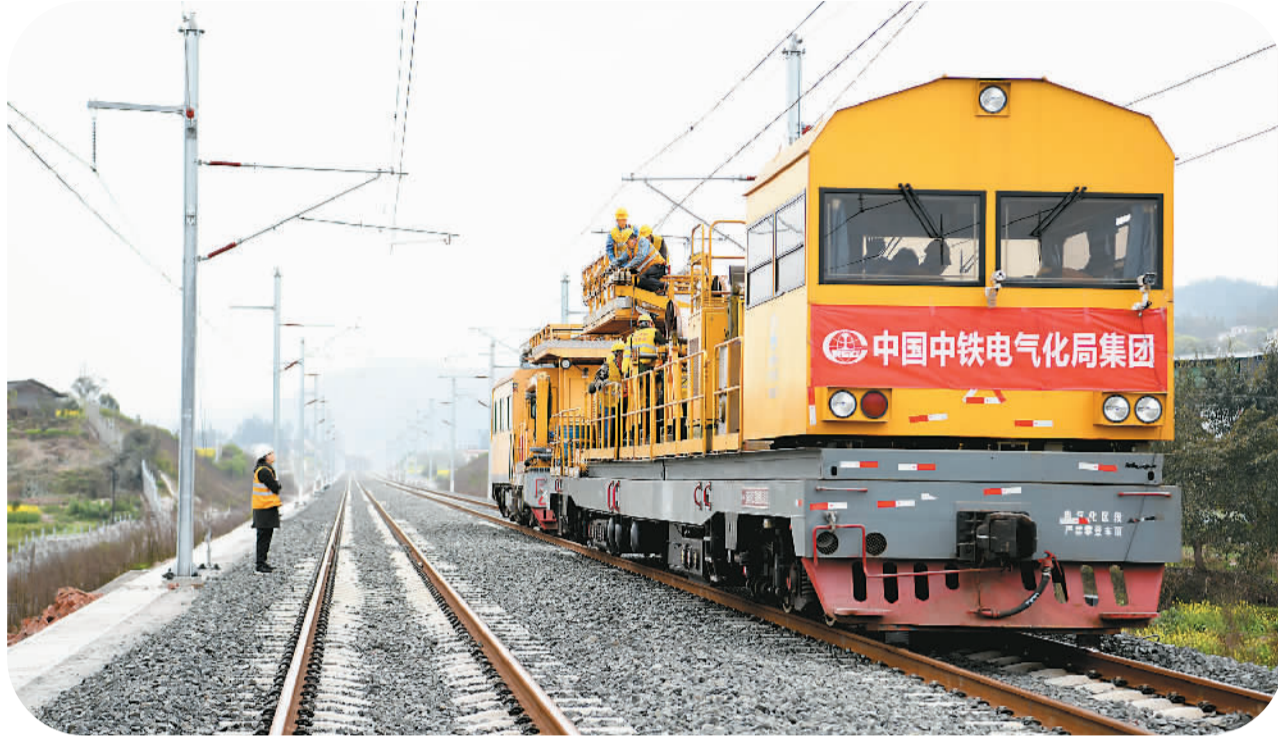
▲近日,为确保川南城际铁路新线建设有序推进,中国铁路成都局集团有限公司全过程参与施工各环节,为川南城际铁路接管后的安全运营工作打下坚实基础。图为2月25日,公司职工正在盯控接触网架线施工。 胡志强摄(人民视觉)
