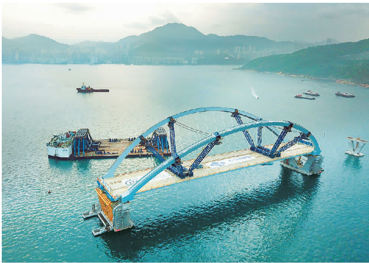
由内地企业独家承建的香港将军澳大桥主桥近日成功安装，这一外飘式双拱钢桥重约1万吨，以高强度钢材建造，跨径200米，建成后将是全港跨度最大和单体最重的钢拱桥，将成为香港又一地标性跨海建筑。 新华社记者 李 钢摄
