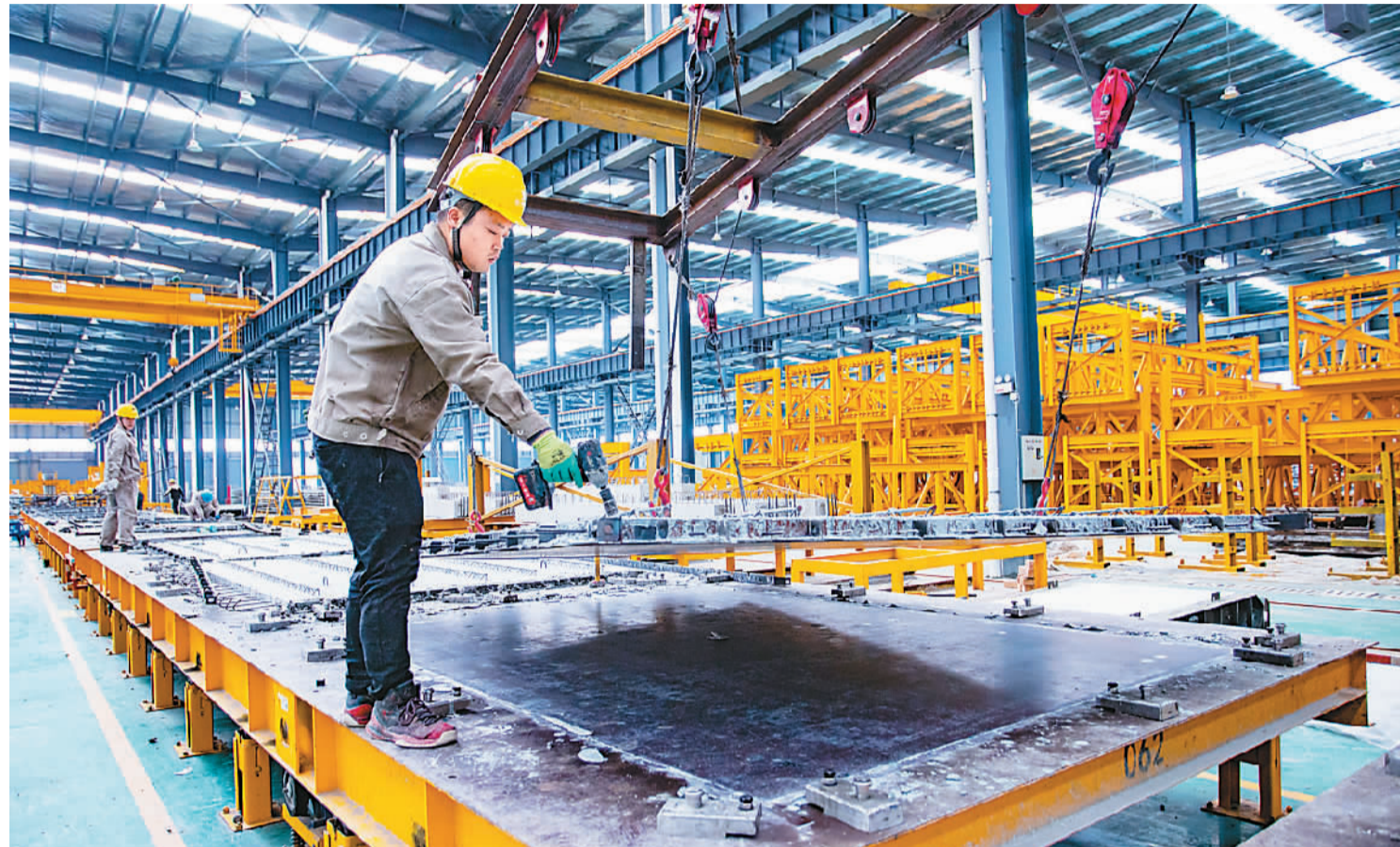
春节假期过后，江西省九江市湖口县高新技术产业园区各企业陆续复工复产，力争新春开门红。图为2月20日，园区内的置地远大建筑公司一派繁忙景象。张 玉摄（人民视觉）
