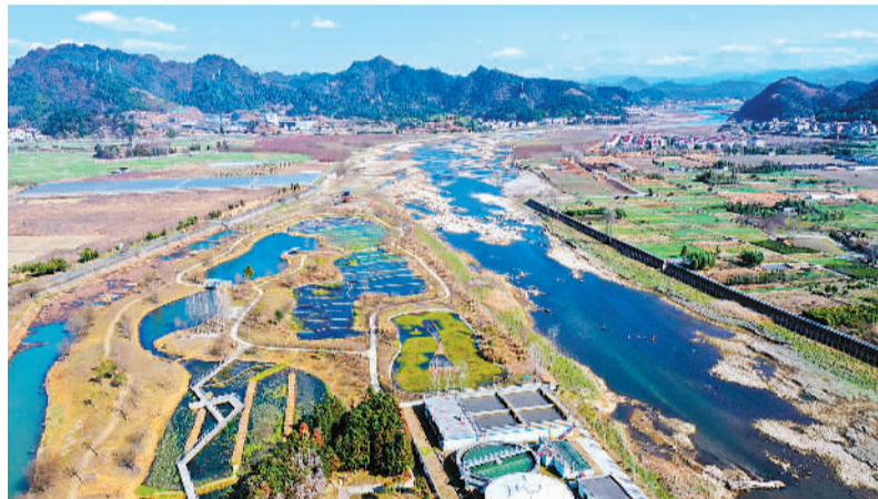
近年来，浙江省杭州市淳安县汾口镇建设综合性生态湿地，使污水处理厂尾水、农业面源污水和农村生活排放污水经湿地再处理、水质再提升。图为2月6日，汾口湿地公园风景旖旎。 谢航凯摄 (人民视觉)
