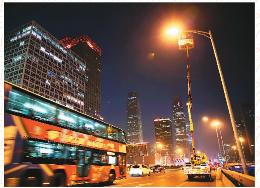
▲ 春节期间，国网北京电力城市照明管理中心加强对重点道路、地区的照明保障和值守工作，为首都市民度过一个欢乐祥和的春节营造良好的氛围。图为该中心工人正在维修北京三环路上的高杆路灯。 本报记者 贺勇摄
