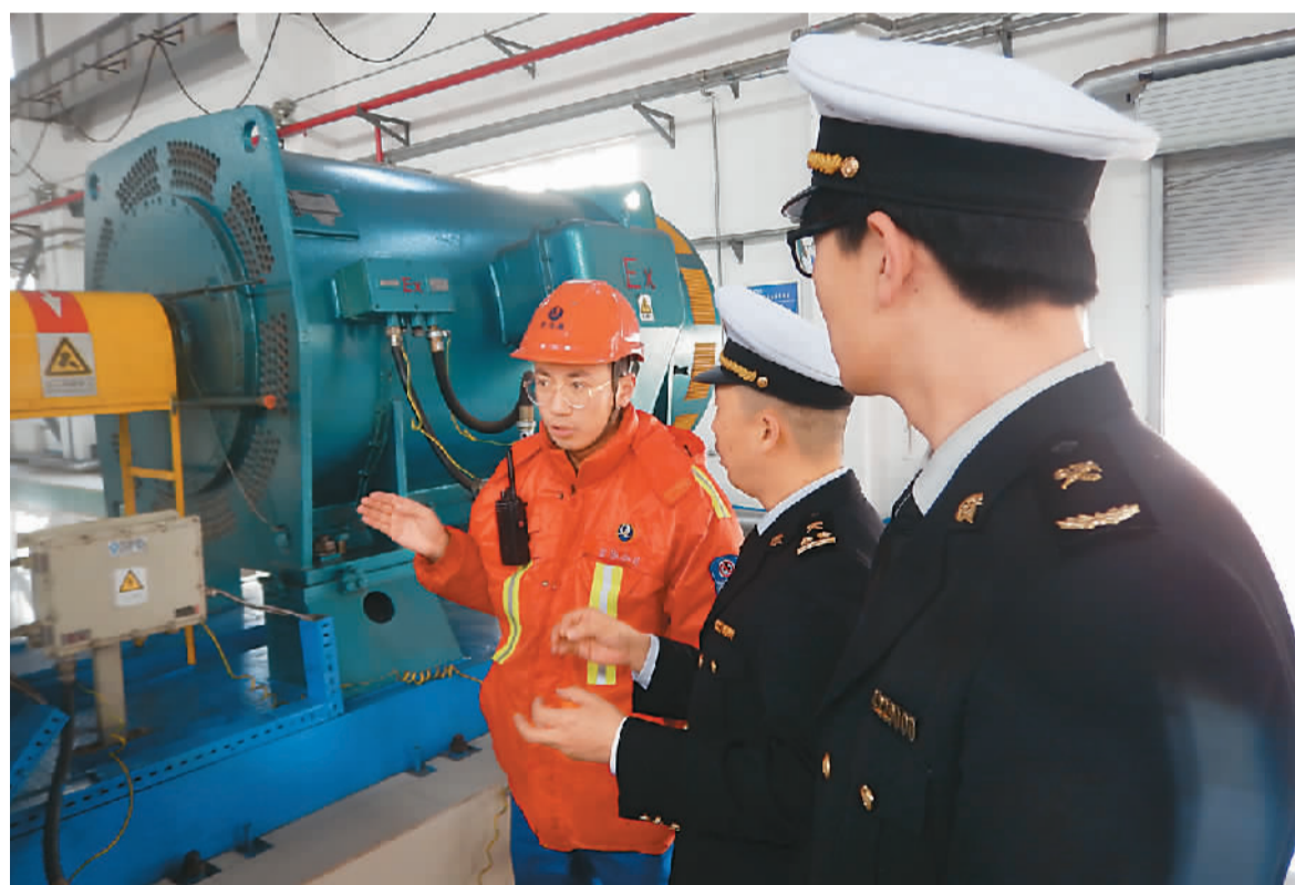
海关关员在泵房监管启动保税原油混兑调和业务。
