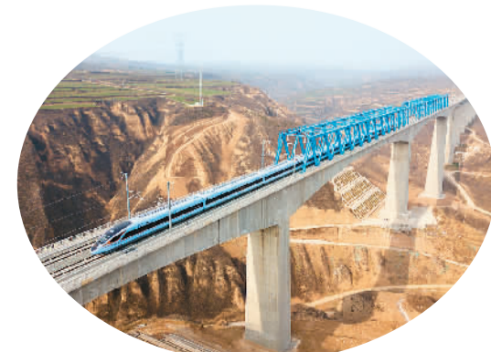
▲近日，银川至西安高速铁路全线开通运营，对推进西部大开发战略实施具有重要意义。因为一列复兴号动车组列车驶过陕西省乾县境内的银西高铁漠谷河二号桥。唐振江摄（人民视觉）
