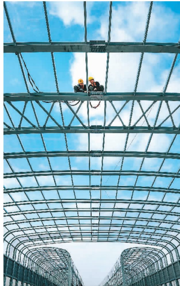
近日，位于广东省佛山市顺德区陈村镇的佛山地铁2号线石洲站的施工现场，铁路建设者正加快推进铁路隧道隔音屏安装。佛山地铁2号线是佛山地铁第二条线路、贯穿佛山东西向的骨干线，计划今年开通运行。 邱新生摄（人民视觉）
