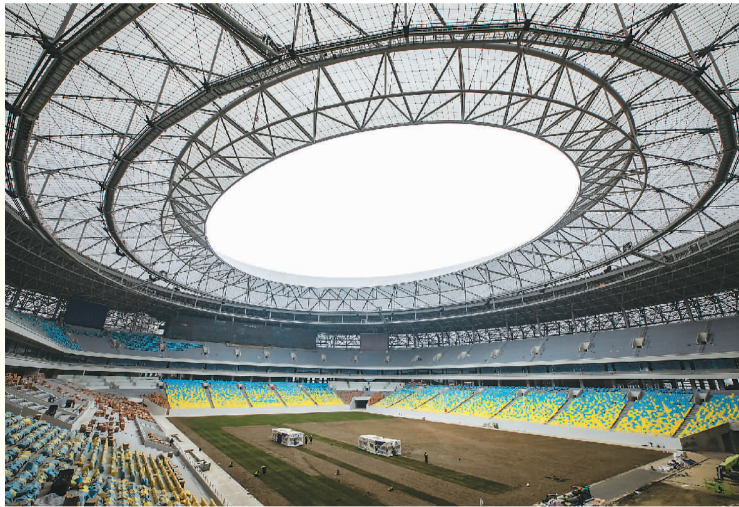
1月27日，工人在四川成都凤凰山体育公园专业足球场施工。目前，第31届世界大学生夏季运动会场馆设施正在加紧建设改造中，主会场东安湖体育公园、核心场馆凤凰山体育公园等13处新建场馆已全部完成主体结构施工，预计将于今年4月全部完工。 新华社记者 沈伯韩摄
