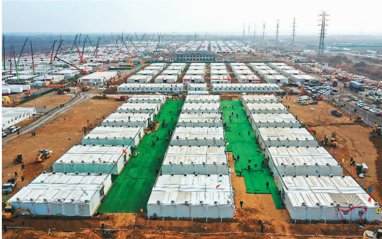
1月19日，石家庄黄庄公寓集中隔离场所606套隔离房和配套设施交付，接下来将再交付1173套。其它工程也在抓紧往前赶。项目选址在正定和藁城交界的黄庄村南，实际占地658亩，建筑规模从初定的3000套增加到4156套。图为工人在工地整理准备交付房屋地面。
