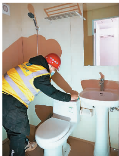
1月19日，工人在石家庄黄庄公寓集中隔离场所工地准备交付的房屋内进行整理。
