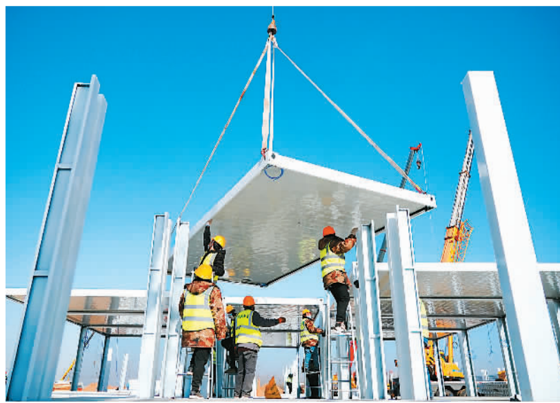
1月18日，工人在石家庄市黄庄公寓集中隔离场所项目工地安装集成房屋。
