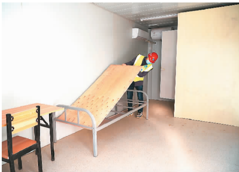
1月19日，工人在石家庄黄庄公寓集中隔离场所工地准备交付的房屋内安装床铺。
