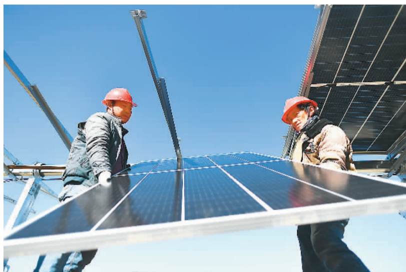
日前，在位于青海省共和县的大唐集团三十万千瓦竞价光伏项目现场，工人正在进行安装。新华社记者 张宏祥摄
