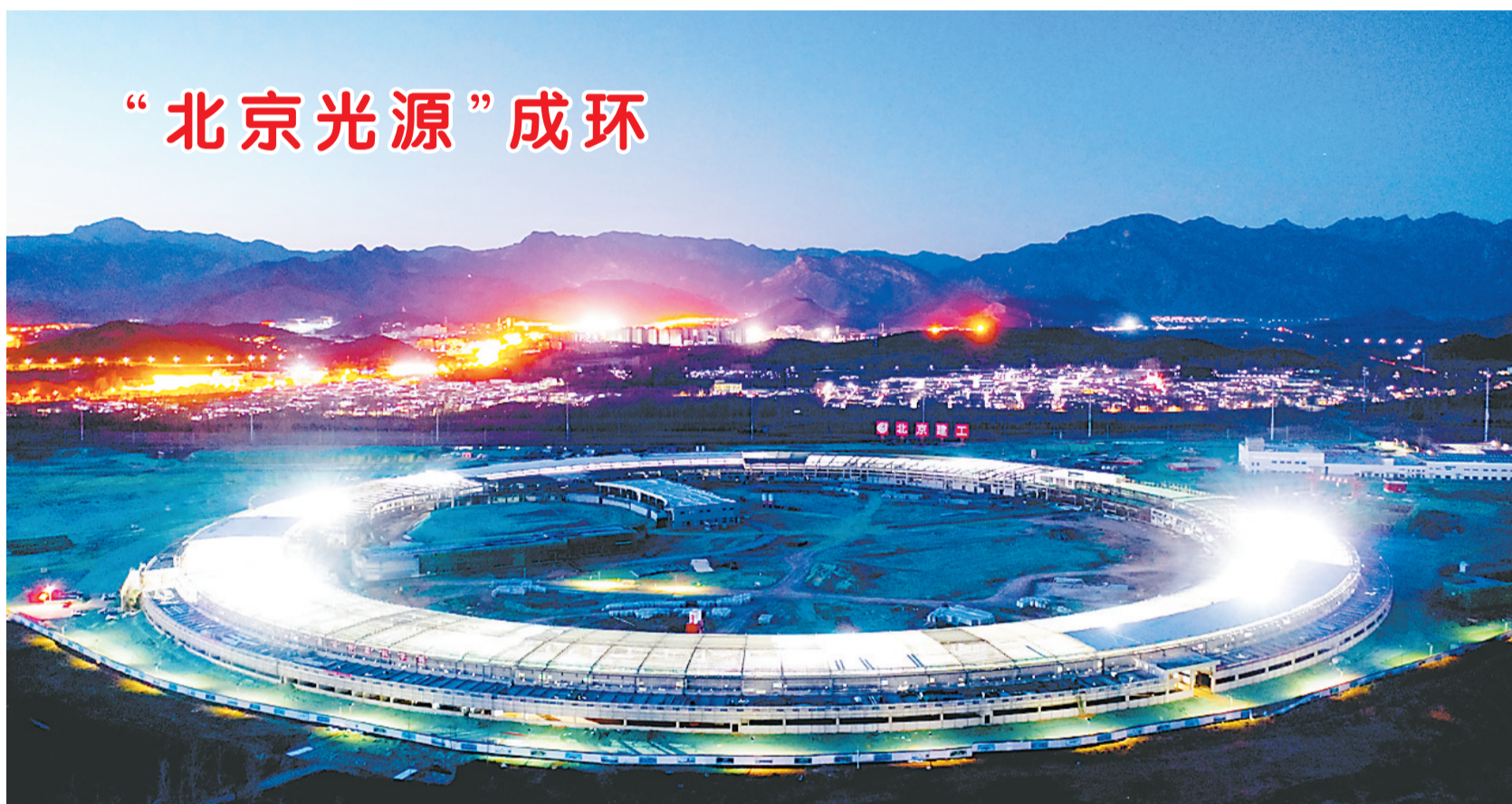
1月上旬,北京建成了国家重大科技基础设施北京高能同步辐射光源主体结构施工,周长1.4公里的“超级光源”正式成环。该项目地处怀柔科学城核心区,总建筑面积约12.5万平方米,建成后将在各项指标参数
