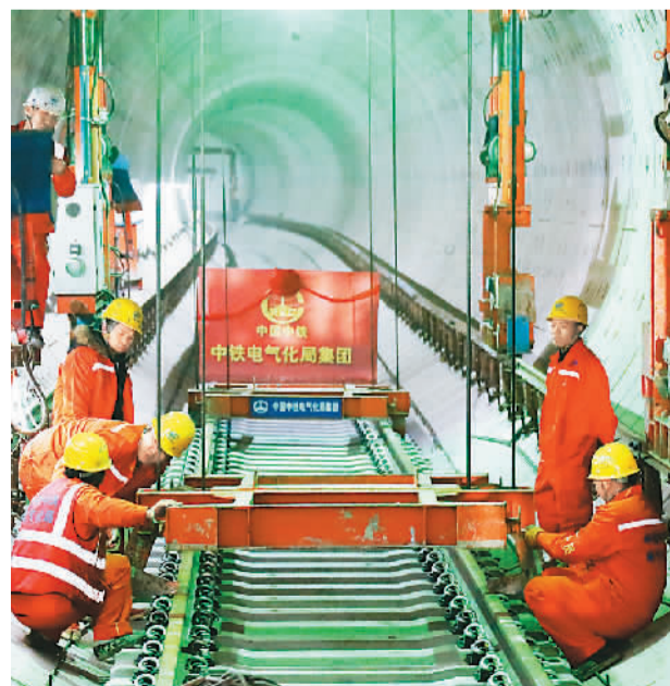
日前，位于湖南省长沙市的中铁电气化局韶光站地铁铺轨基地，两台大型轮轨式龙门吊将长达25米的轨排稳稳抓起，稳稳地落在轨道地下线。图为工人正在进行铺轨作业。
