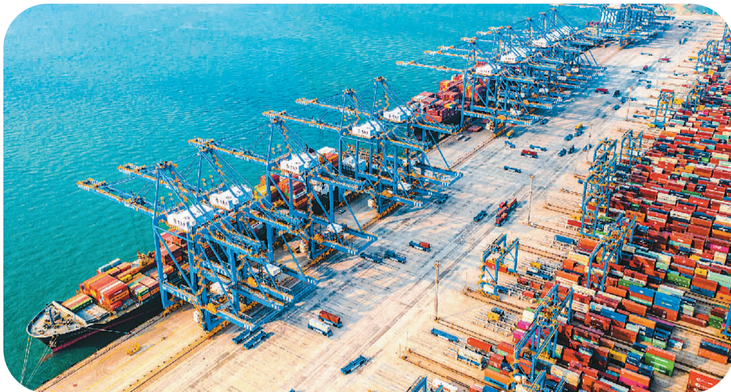
2020年12月，山东港口青岛港自动化码头创出47.6自然箱/小时的桥吊单机作业效率，第六次刷新自动化码头桥吊单机效率世界纪录。图为青岛港码头的一角。(山东港口集团供图)
