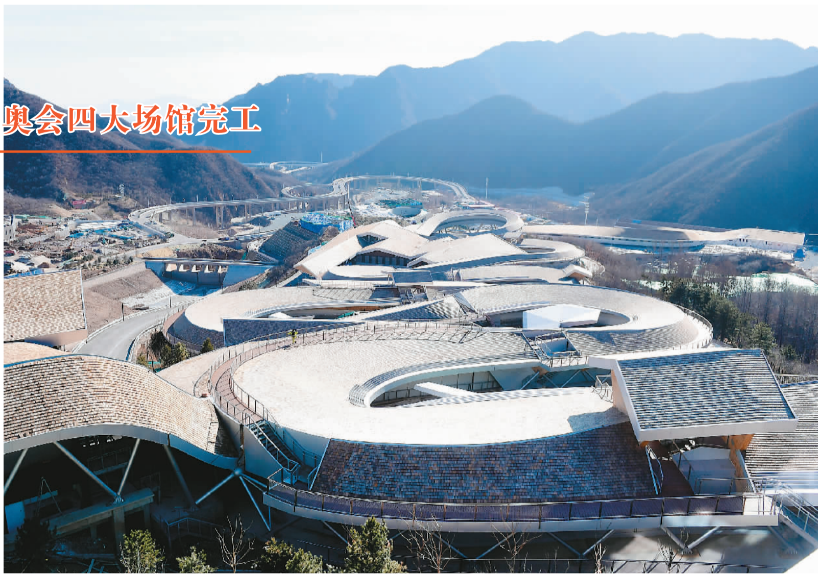
12月29日,北京2022年冬奥会延庆赛区国家高山滑雪中心、国家雪车雪橇中心、延庆冬奥村及山地新闻中心四大场馆完工。图为国家雪车雪橇中心。新华社记者张晨霖摄
