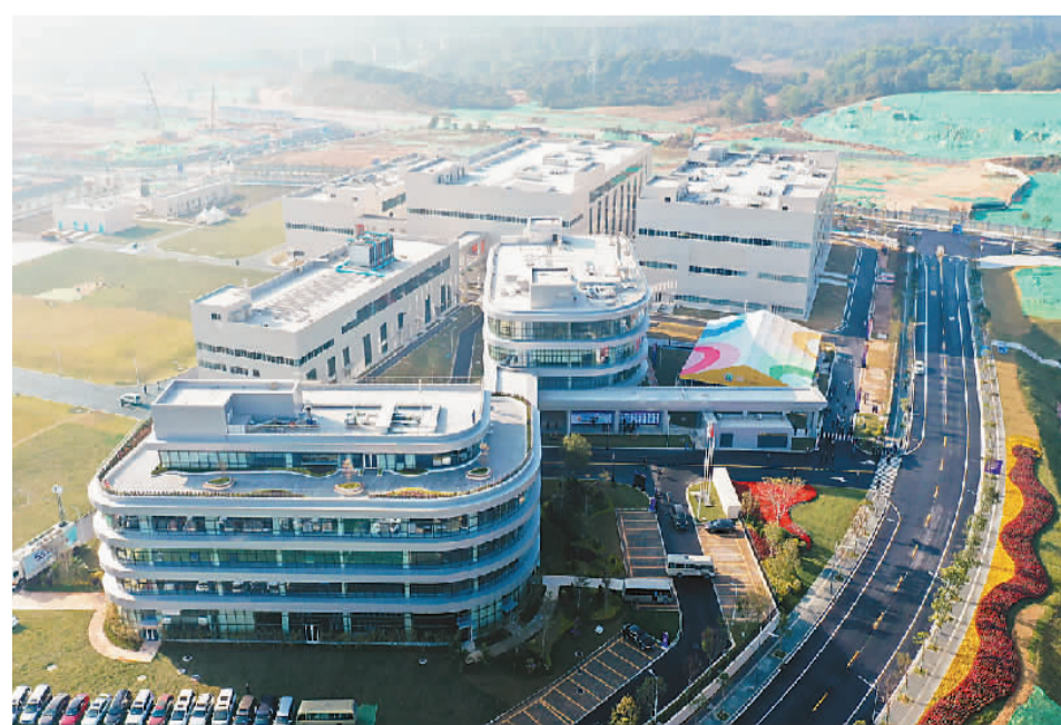
诺诚健华广州药品生产基地一期项目竣工现场。
