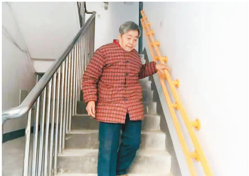
图为在江苏省无锡市隐秀苑147栋，楼道里安装了双层扶手，为老年人上下楼梯“搭把手”。 无锡滨湖发布供图
