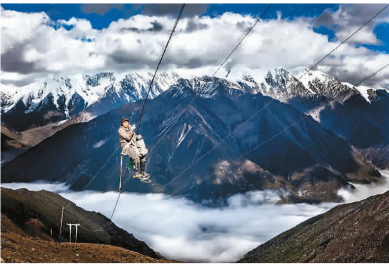
2017年10月24日，四川康定贡嘎山子梅垭口，电信工人在铺设宽带网络到雪山下的子梅村。图为“一个也不能少——全国脱贫攻坚摄影展”展出作品。胡南丹摄
