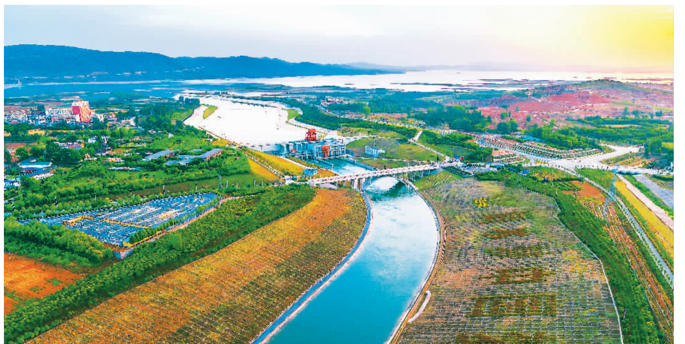
▲南水北调中线陶岔渠首工程。
