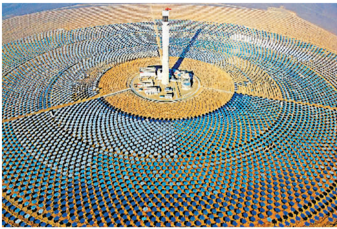
近年来，新疆哈密市依托当地丰富太阳能资源，不断加大太阳能发电项目的建设力度，目前已有20多家企业落户哈密，光伏发电电站装机规模突破170万千瓦。图为哈密市伊吾县淖毛湖镇中电工程哈密熔盐塔式5万千瓦光热发电站一角。蔡增乐摄（人民视觉）
