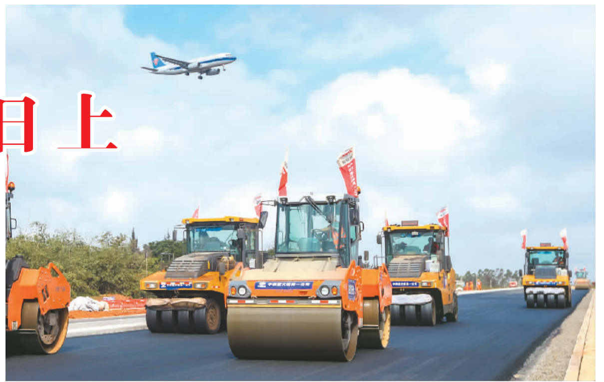
目前，海南省海口市抓住海南自贸港建设机遇，着力以综合交通枢纽为核心，分批有序推进基础设施项目，骨干路网正加速成形。图为日前在位于海口市江东新区的海口绕城公路美兰机场至演丰段施工现场，工人开着压路机铺设沥青。
