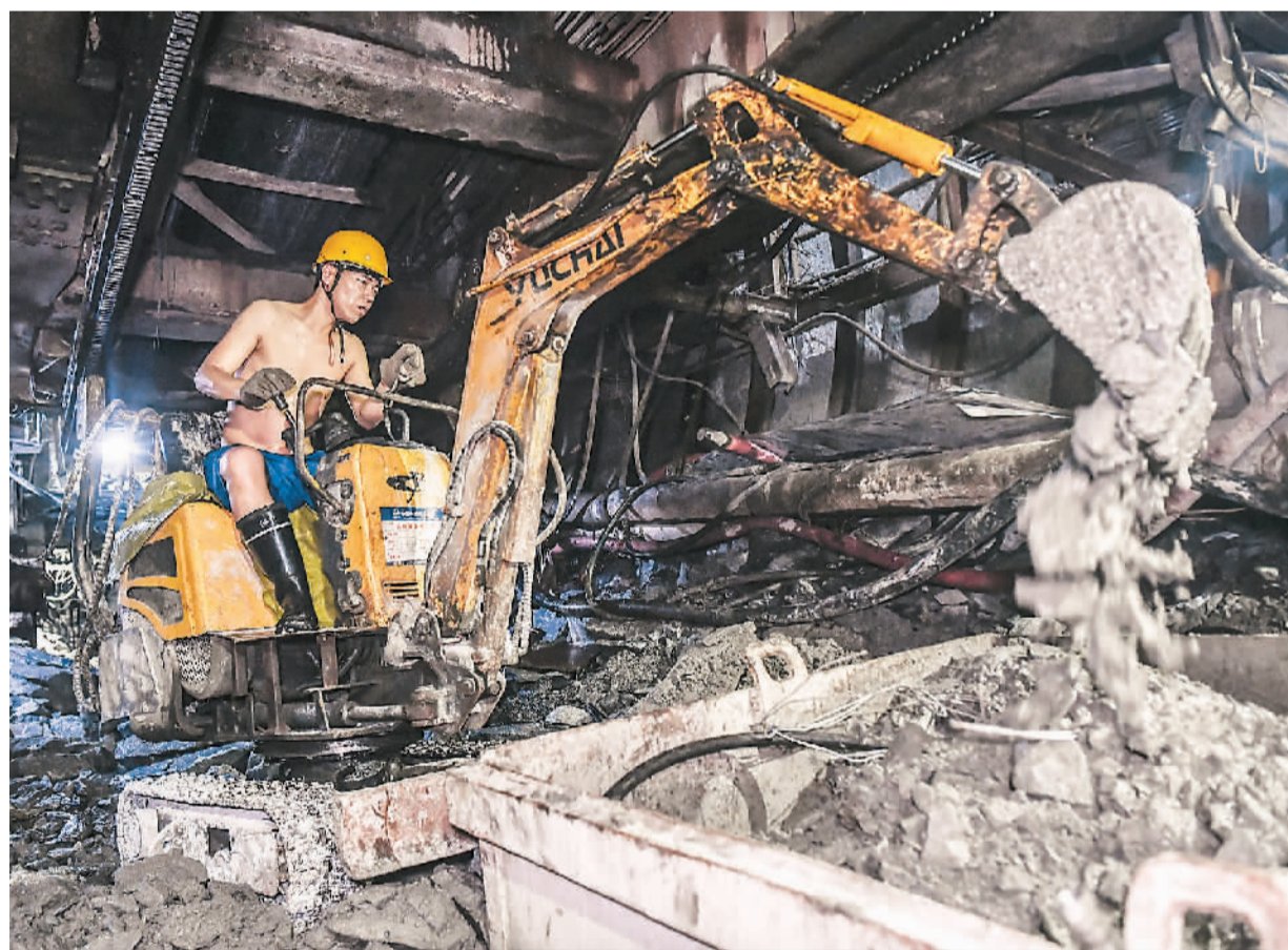
▶工人在掘进机的底部清理渣石。
