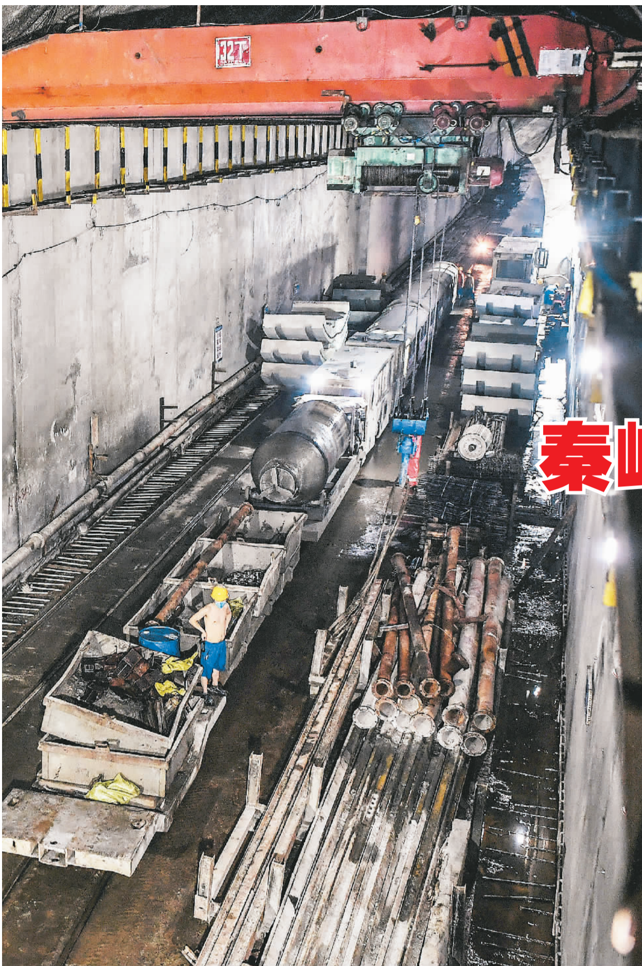
▲工人在掘进机的底部搬运钢拱架，进行隧洞初步支护。
