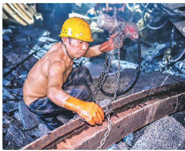
▲工人在掘进机的底部搬运钢拱架，进行隧洞初步支护。
