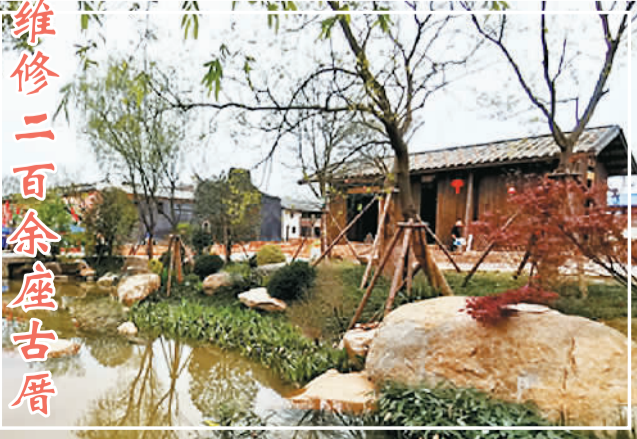
梁厝特色历史文化街区位于福州三江口梁厝村。随着修缮进度不断加快，梁厝特色历史文化街区首批48处古建筑有望在世界遗产大会召开前与市民见面。图片来源：福州晚报
