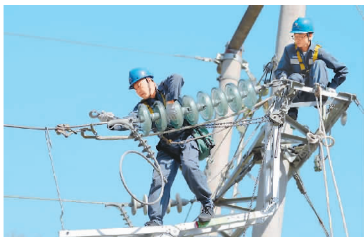
立冬以来，贵州省黔东南苗族侗族自治州兴义市用电负荷攀升，为确保输电线路安全稳定，南方电网贵州兴义供电局开启输电线路巡检维护工作。图为维修人员在巡检输电设备。 卢关文摄
