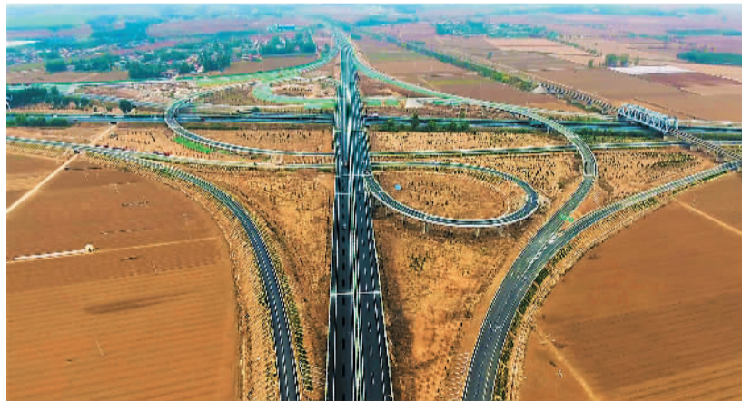
由山东高速集团和中建八局共同投资、建设的山东宁阳至梁山段高速公路近日建成通车。该段连接济宁与泰安两市，全长约110公里，设计时速120公里/小时。李永明 崔文一摄影报道
