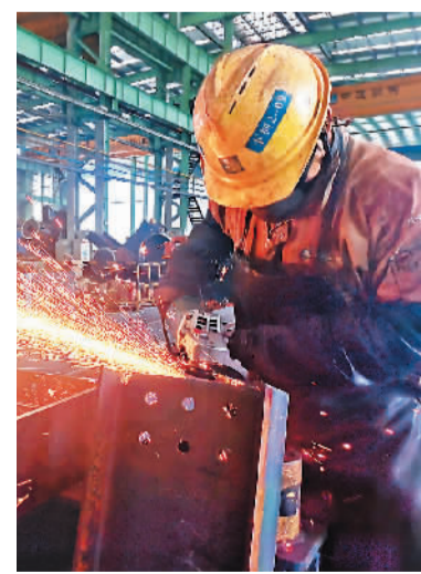
图为工人在中建钢构四川有限公司制造厂进行焊接作业。潘帅摄（人民视觉）
