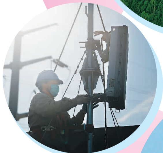
在南京220千伏城南河变电站屋顶，工人在架设5G设备
