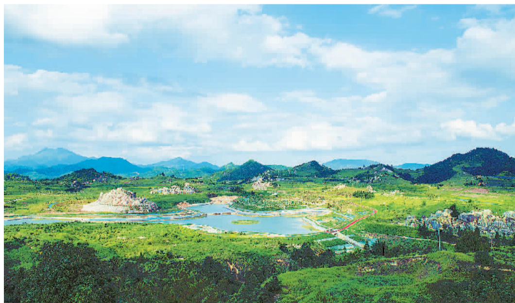
江西省赣州市山水林田湖草生态保护修复试点——寻乌县文峰乡柯树塘废弃矿山环境综合治理与生态修复工程。 清晓晖摄
