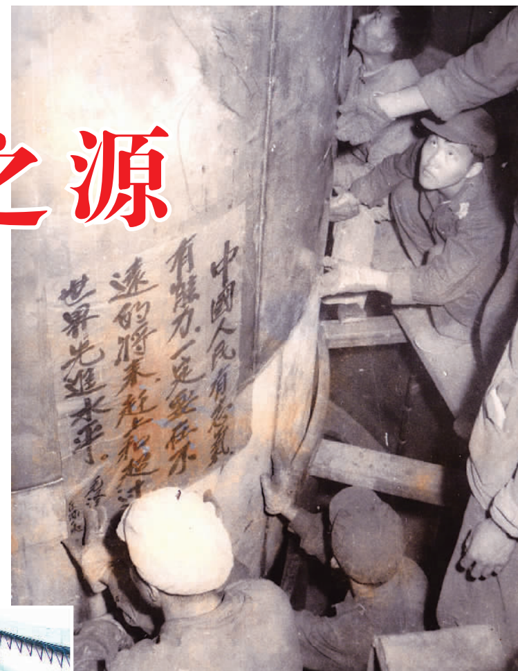
▲1969年，第一代核潜艇陆上模式堆的压力容器正式安装就位。容器外面贴着一幅字：“中国人民有志气、有能力，一定要在不远的将来，赶上和超过世界先进水平。”中国核动力院供图
