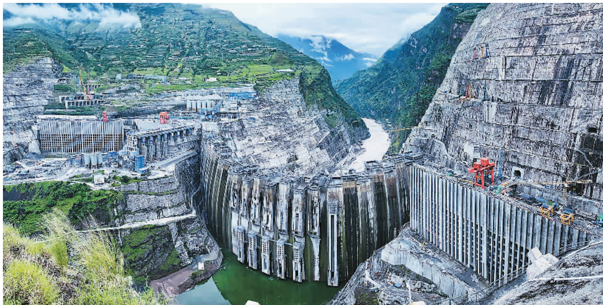
图为白鹤滩水电站建设现场。
