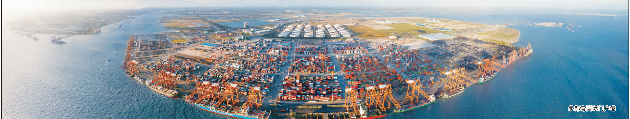
广西北部湾港钦州国际集装箱码头
