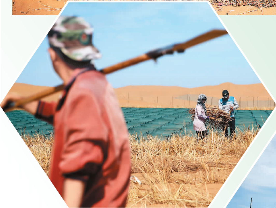
▲ 治沙工人在穿越腾格里沙漠腹地的乌玛高速青铜峡至中卫段搬运扎草方格的麦草。新华社记者 冯开华摄 ◀ 治沙工人在扎草方格。新华社记者 贾浩成摄
