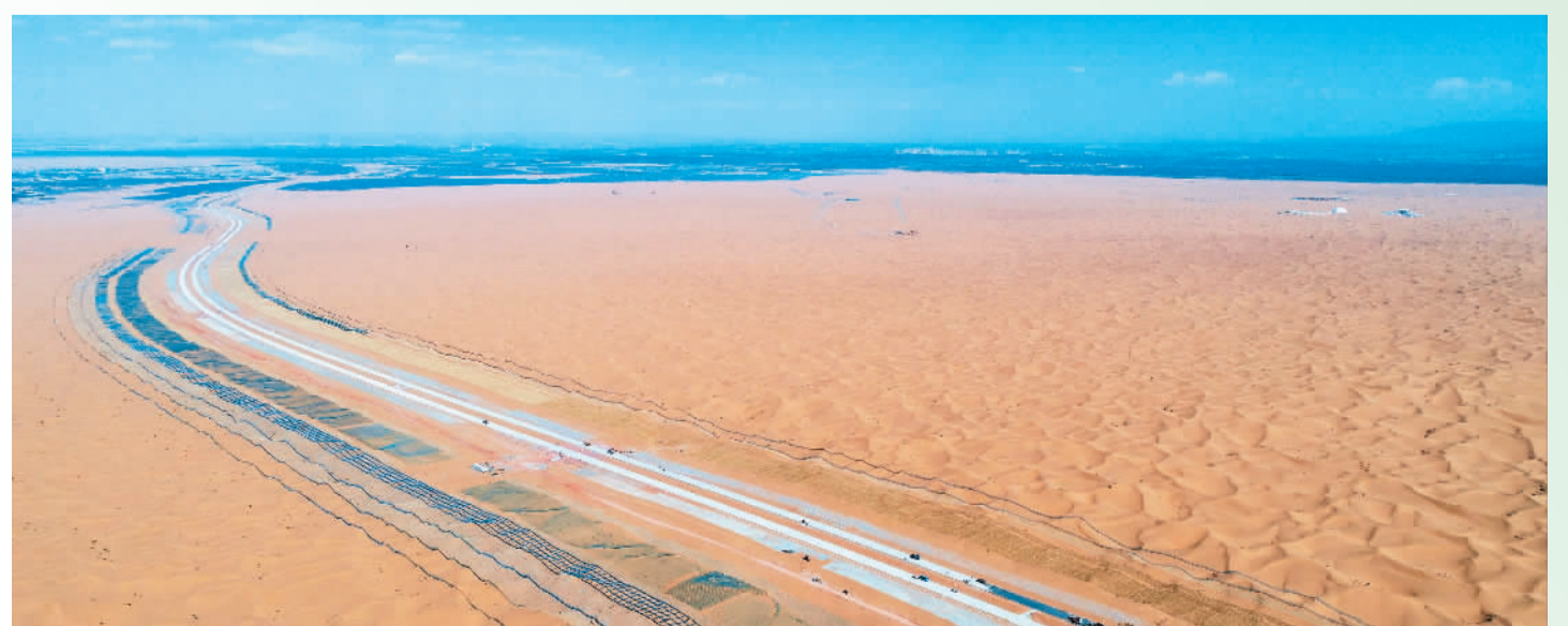
▲ 穿越腾格里沙漠腹地的乌玛高速青铜峡至中卫段施工现场。新华社记者 冯开华摄
