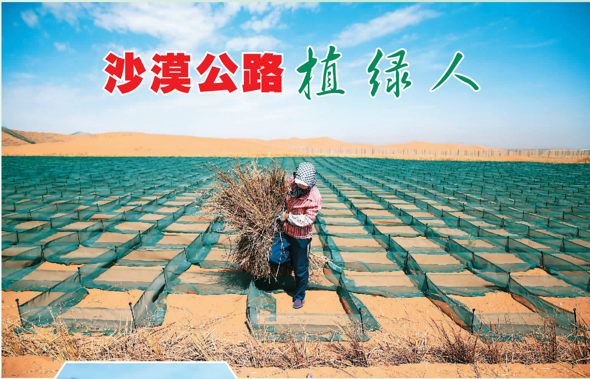
▲ 治沙工人在穿越腾格里沙漠腹地的乌玛高速青铜峡至中卫段搬运扎草方格的麦草。新华社记者 冯开华摄 ◀ 治沙工人在扎草方格。新华社记者 贾浩成摄
