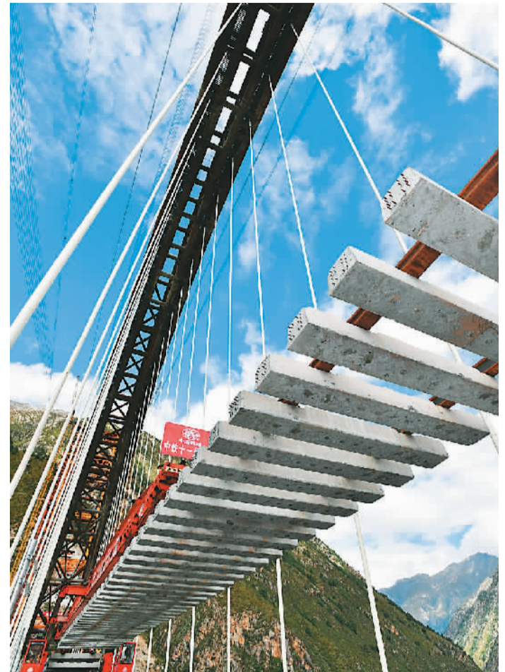
9月20日，拉萨至林芝铁路第三座跨越雅鲁藏布江特大桥正线铺轨168公里，距离2021年建成通车更近了一步。拉萨至林芝铁路是国家“十三五”规划重点工程项目，全长435公里，设计时速160公里，是西藏首条电气化铁路。图为中铁十一局工程技术人员在藏木特大桥上铺轨。新华社记者 觉果摄
