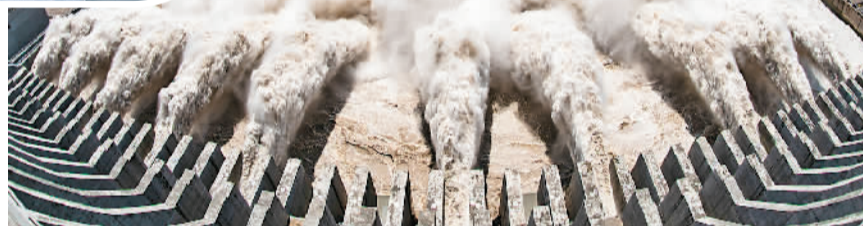
►图为8月19日，正开启泄洪深孔泄洪的三峡大坝。郑家裕摄
