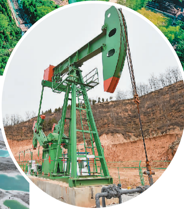
▲近年来，山西省加快推进煤层气资源开发利用。图为山西燃气集团武乡南区块煤层气井的排采现场。柴婷摄（新华社发）
