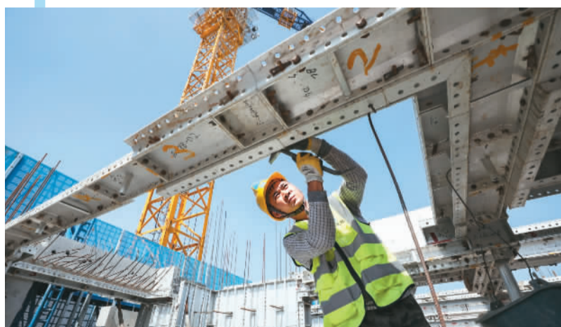
江苏南京，工人在百水保障性住房一期项目工地加紧施工，该保障性住房以三星级绿色建筑为目标。 赵启瑞摄（人民视觉）
