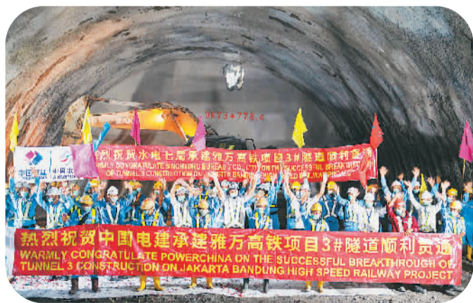
4月26日，在印度尼西亚雅万高铁3号隧道，工人们庆祝隧道贯通。新华社记者 杜宇摄
