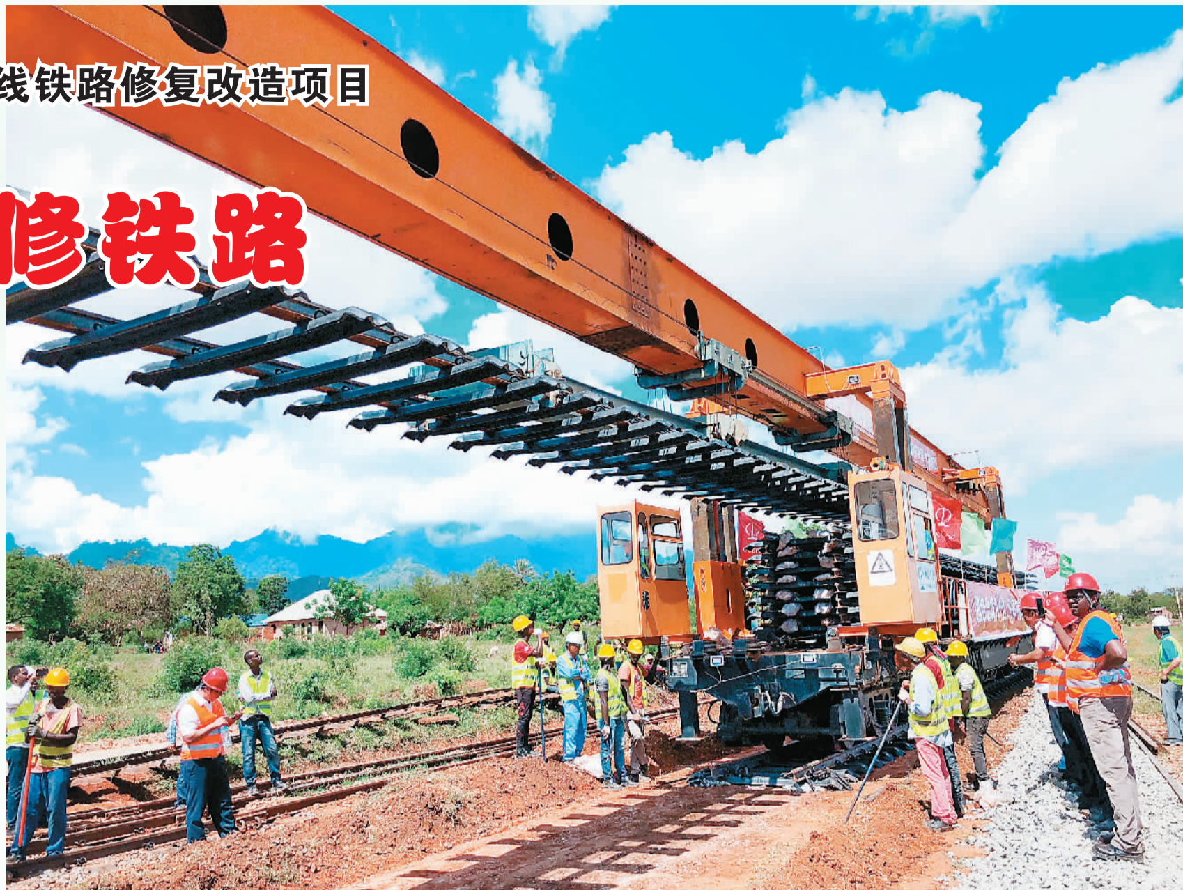
▲ 在坦桑尼亚中央线铁路修复改造项目现场，工人们在进行机械化铺轨施工作业。
