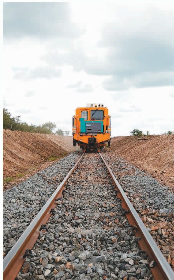
▲ 重型捣固机在坦桑尼亚中央线铁路修复改造项目上作业。 ▼ 坦桑尼亚中央线铁路。
