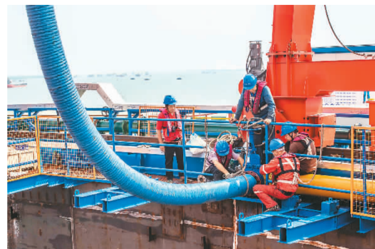
常泰长江大桥沉井下沉设备总容量达6000千伏安，采用岸电供应。图为在大桥建设工地，工人在对5号墩钢沉井气举吸泥管进行安装。 汤德宏摄（人民视觉）
