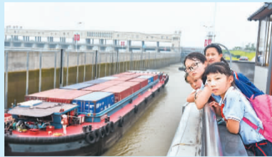
浙江省金华市环城小学的学生到衢江婺城航运开发项目现场，参观衢江婺城绿色航运建设过程。 李健林摄（人民视觉）
