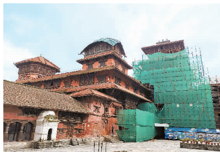
左图：2015年大地震使九层塔上部坍塌，东北角塔被震毁，九层神庙建筑群面临墙体开裂及变形、披檐瓦面破损等病害。(拍摄于2015年10月)
