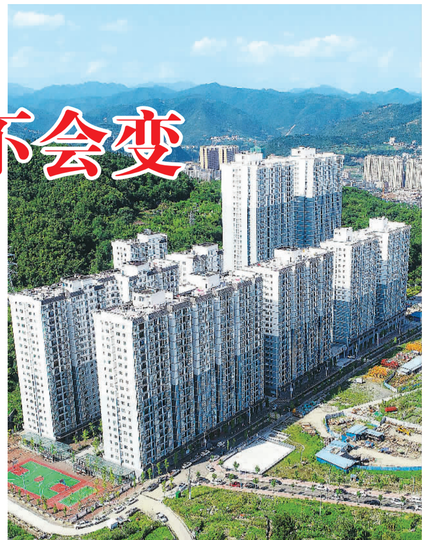
日前,湖北省竹山县杜家沟公租房建设项目通过竣工验收,为低收入人群提供可靠保障。邵义龙摄(人民视觉)
