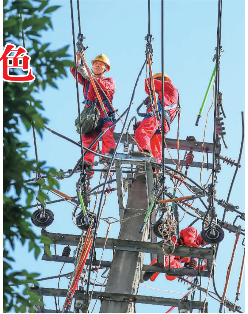
七月二十八日，国家电网四川省华蓥供电公司检修队队员冒着摄氏三十八度的高温，在该市红星四路口及时抢修由于负荷过重而损坏的供电设备。邱海鹰摄（人民视觉）
