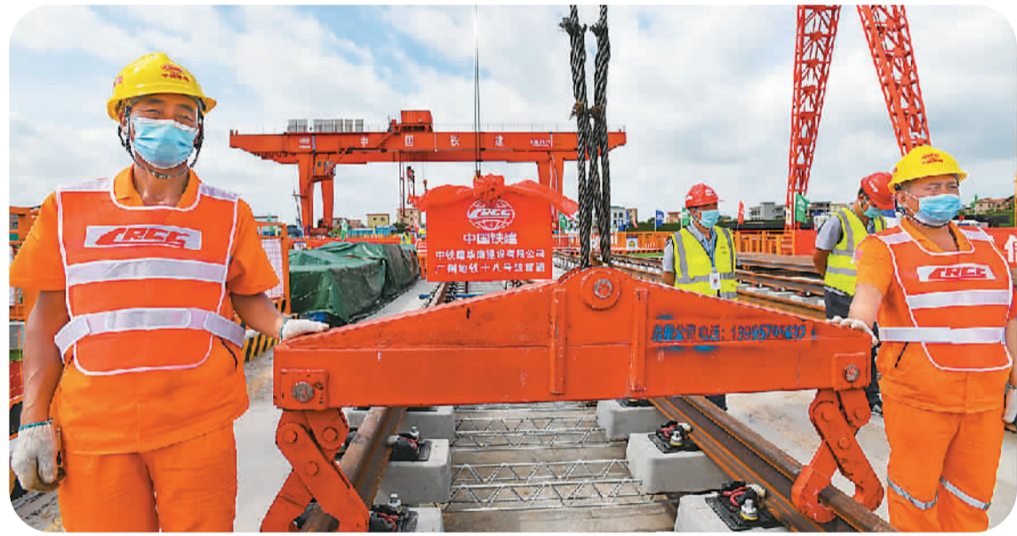
粤港澳大湾区重点基础设施建设项目广州地铁18号线近日开始铺轨。
