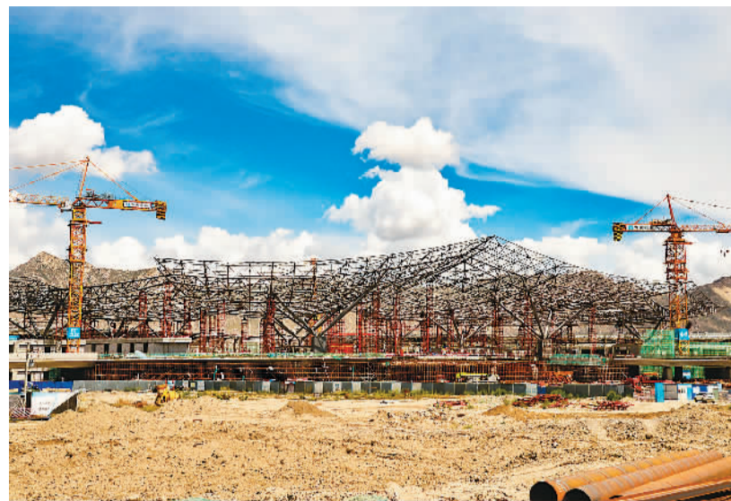
7月27日,西藏自治区拉萨贡嘎国际机场新建T3航站楼钢结构实现封顶,标志着T3航站楼主体结构施工完毕,工程全面进入装修施工阶段。图为拉萨贡嘎国际机场T3航站楼施工现场。新华社记者田金文摄
