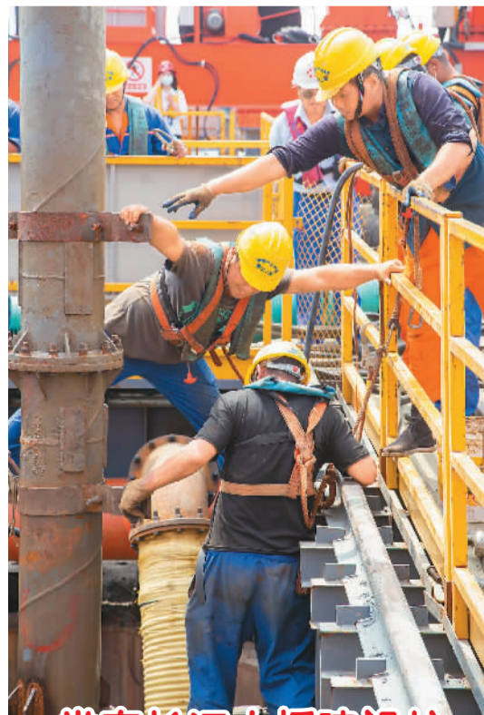
常泰长江大桥建设忙
