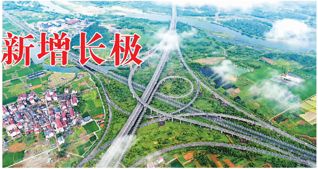
近年来，浙江省台州市仙居县交通基础设施不断完善，通达八方的交通网为融入长三角区域一体化发展提供有力支撑。图为浙江诸永高速台州市仙居县白塔枢纽如“巨龙”出海。 王华斌摄 (人民视觉)
