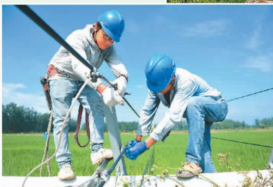
受7月22日晚上大风暴雨影响，江苏省徐州市睢宁县古邳镇10千伏西线官庄西台8根电杆倒在稻田中，造成部分用户停电。灾情发生后，当地供电部门迅速组织人员前往抢修，并及时恢复供电。图为23日，睢宁县电力抢修人员在古邳镇官庄村抢修供电线路。
