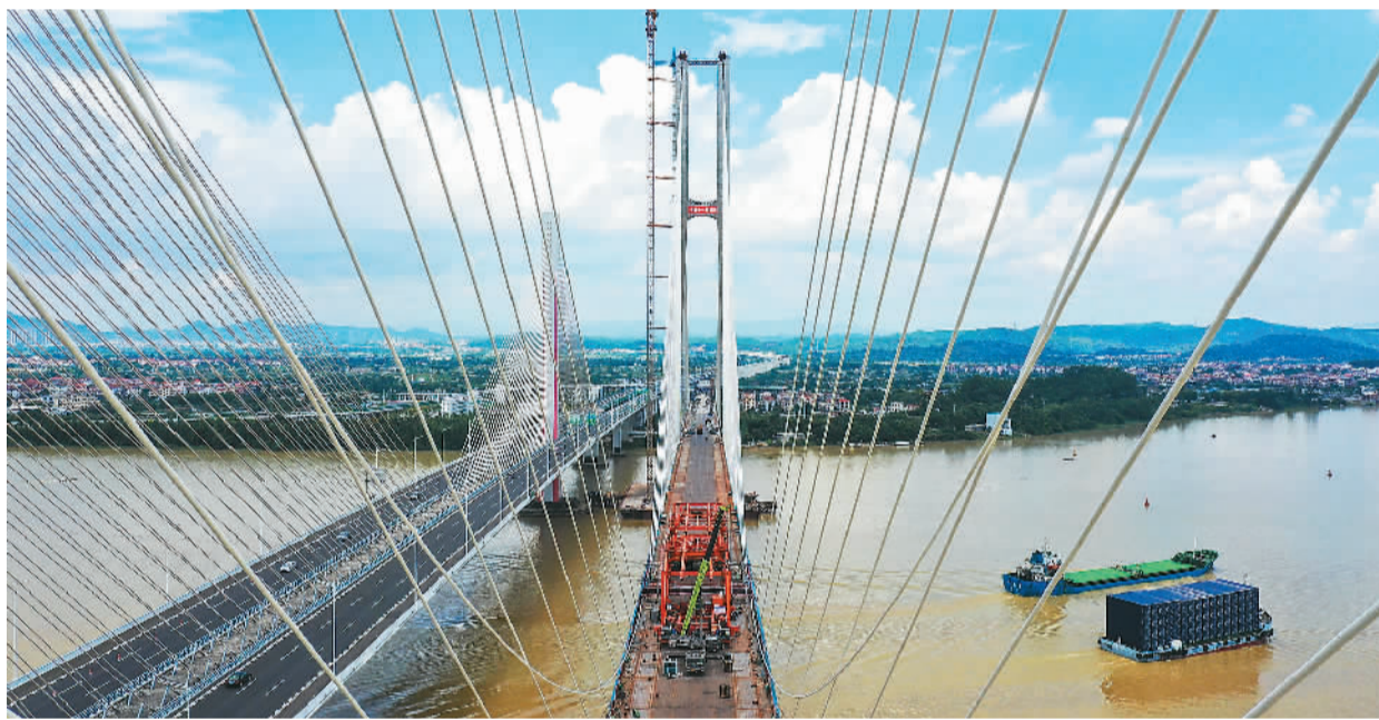
7月22日，中铁十一局承建的粤港澳大湾区基础设施“硬联通”重点工程——广州南沙港铁路跨西江特大斜拉桥完成最后一组斜拉索吊装，大桥预计在7月底合龙。图为大桥最后一组斜拉索吊装的现场。新华社记者 刘大伟摄
